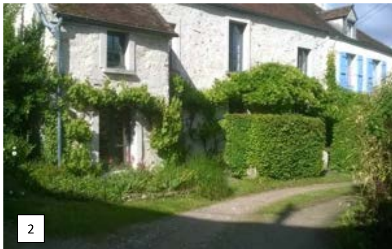
Maison en pierre avec végétation sur façade
