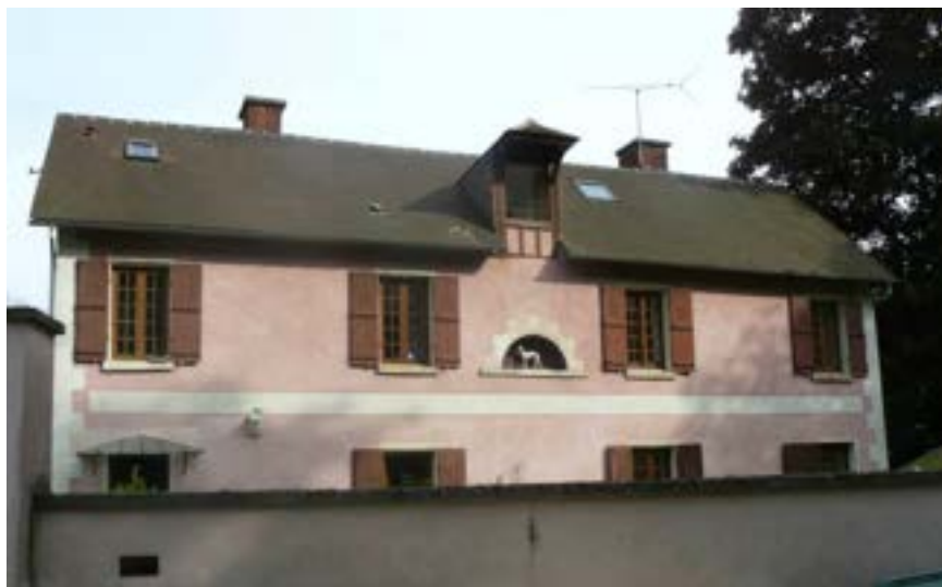
Ancien pavillon de chasse dit La levrette, chemin de la Vallée Pierreuse
