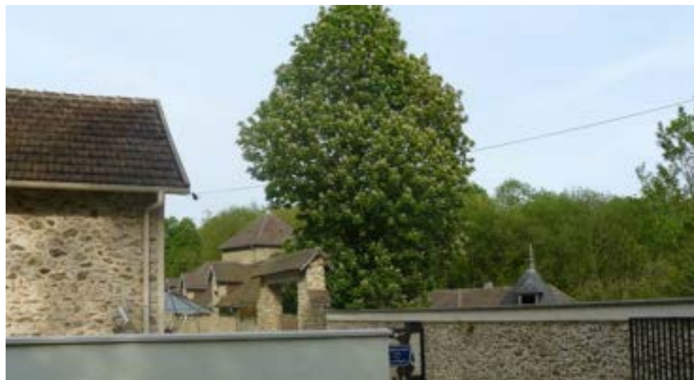
Bâtiments agricoles de la ferme de La Levrette
